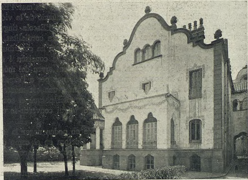
CASA DELS NENS. INSTITUCIÓ MUNICIPAL MONTESSORI. ALTRE DETALL DE LA FAÇANA DEL JARDÍ
